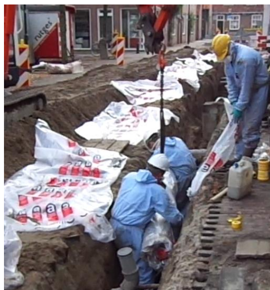
Figuur 3.9.d: Dubbel inpakken van de buis
