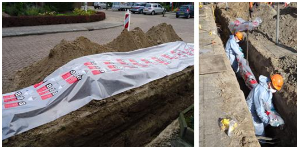
Figuur 3.9.g: Dubbel inpakken van de leiding naast de sleuf of in de sleuf
