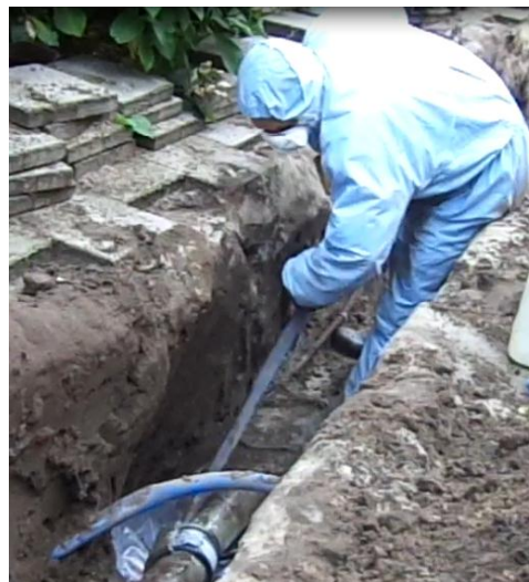
Figuur 3.9.b: Het verbreken van de mof
