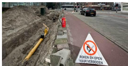
Figuur 3.6.b: Langsafzetting / markering of niet? (foto Stedin (Stedin, 2011)), zie ook bijlage IX.
