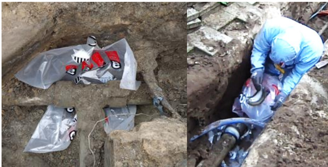
Figuur 3.9.e: Folie onder de verbindingsmof
